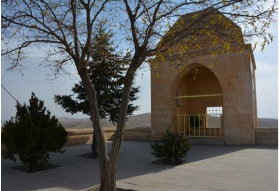
Resim 7. Türbenin kuzey cephe görünüşü (H. İ. Kunt'tan)
